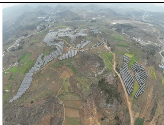
地块 2 光伏方阵区全景
