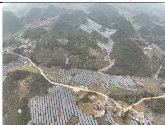
地块 4 光伏方阵区全景
