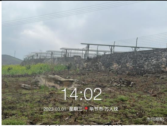
地块1 干砌石挡墙
