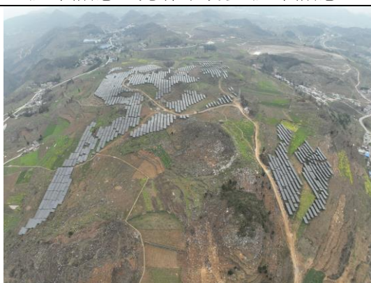
地块 1 光伏方阵区全景
