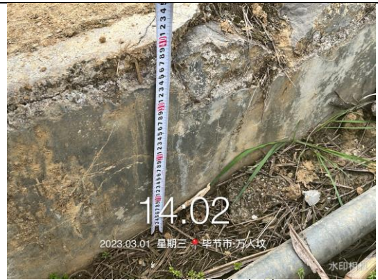
地块1 道路排水沟
