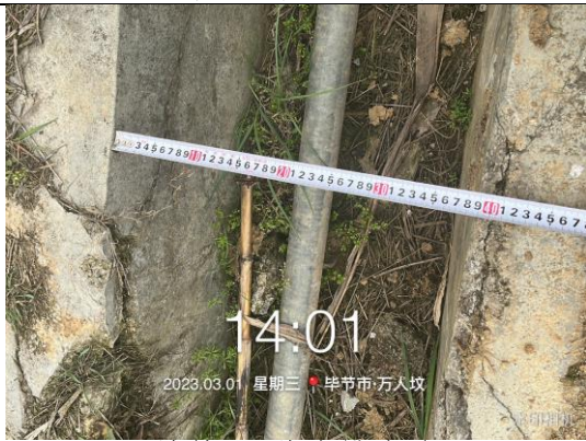
地块1 道路排水沟
