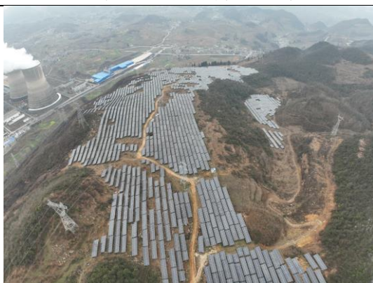
地块 3 光伏方阵区全景
