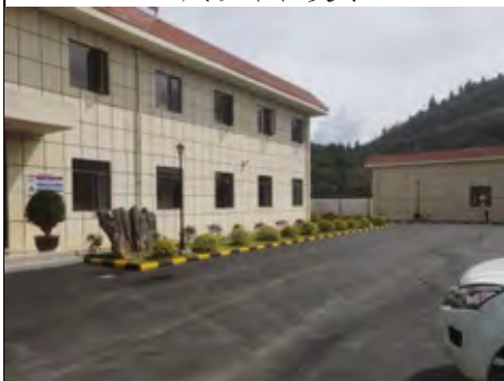
升压站内绿化
