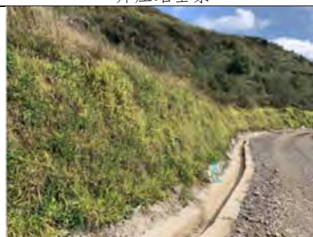
场内道路及排水沟
