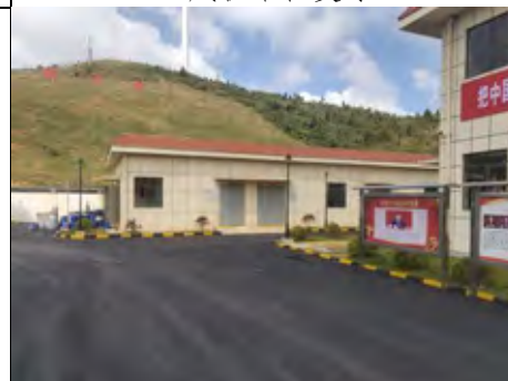
升压站内绿化
